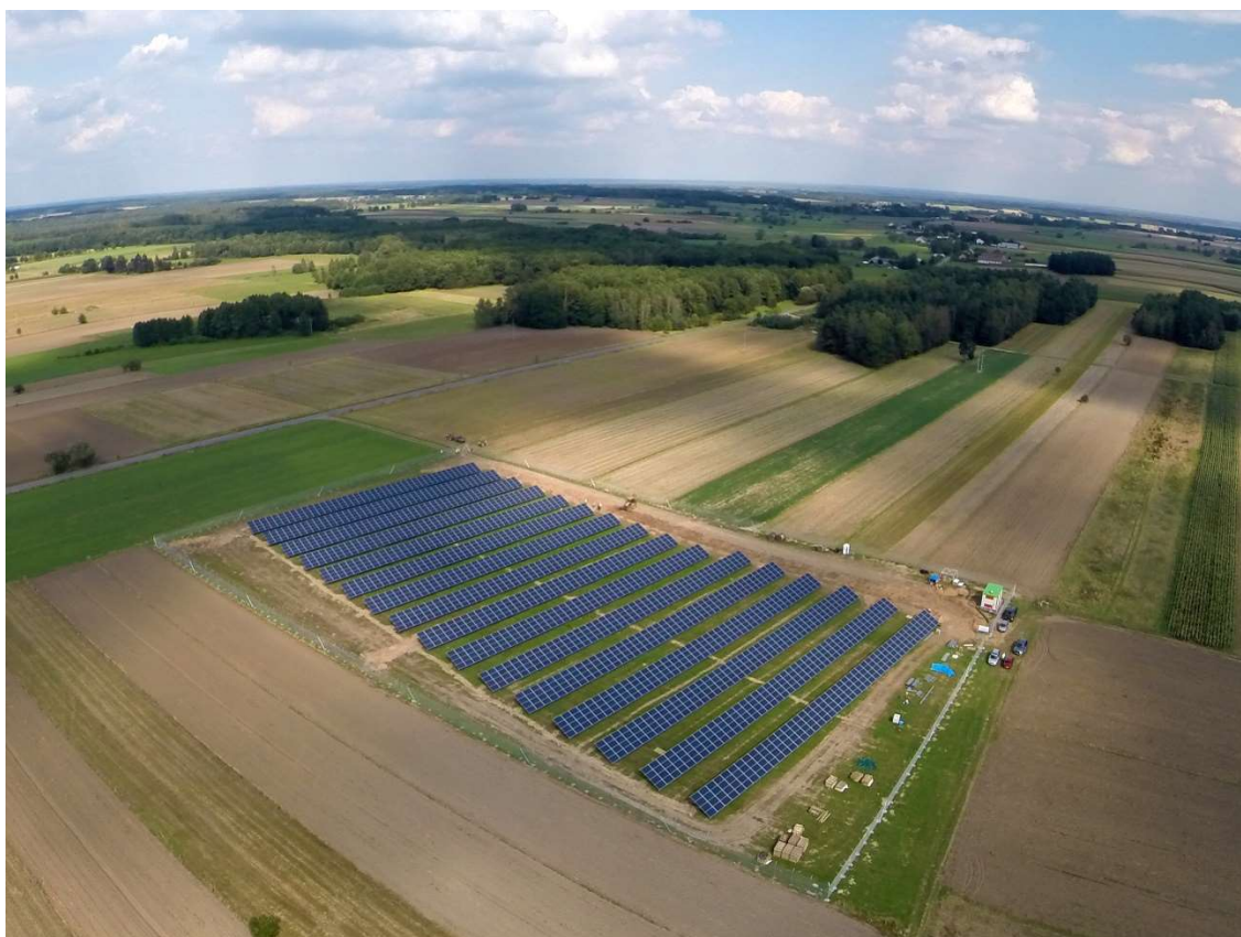
Elektrownia Słoneczna R.Power - Jedwabne
